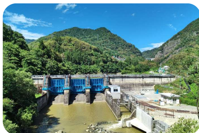
湯の瀬ダム・湯の瀬いとおしき発電所
